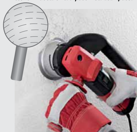
Покрытые краской обои вскрываются с помощью зуборезных долбяков модернизированного перфоратора. Благодаря этому жидкость (растворитель для обоев) быстрее проникает в отверстия.
