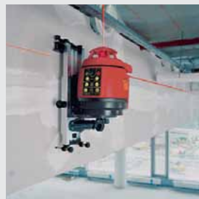
Подвешивание потолков с помощью ротационного лазера, дистанционного управления и оптимального держателя для стен и потолков проходит без труда.
