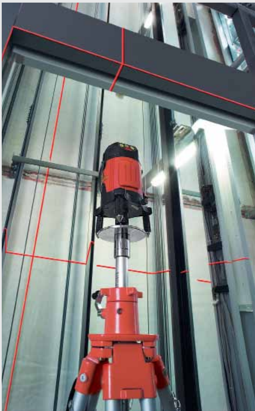
При монтажных работах с помощью горизонтальной лазерной линии и двух подключаемых вертикальных линий проецируются основные пространственные плоскости и обеспечивается быстрое выравнивание.
